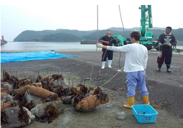
クレーンに資材を設置
