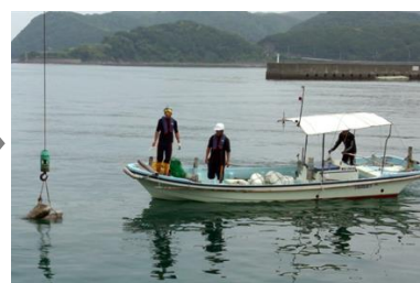
クレーンで海底に設置
