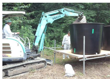
人工腐植生産容器に材料を投入
