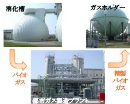
金沢市臨海水質管理センター 都市ガス製造プラントによる精製バイオガスを隣接する市営都市ガス工場へ供給。(平成17年度より供用開始)
